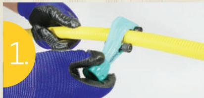
Couper le tuyau PLT PAKTERMO à l'aide du coupe tube fourni par le fabricant. Couper à travers la gaine synthétique et le tube en acier inoxydable avec un coupe-tube à molette en acier tranchant. Couper le tube en creux d'onde puis faire tourner la coupe tube dans une seule direction en resserrant la molette de pression progressivement après chaque rotation. Ne pas serrer trop fort le coupe-tube sinon vous risquez de déformer l'extrémité du tuyau.
