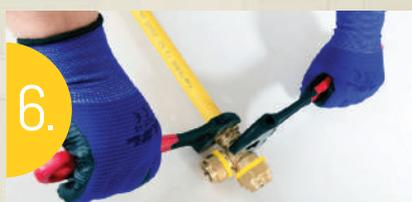
Insérer le tuyau dans le raccord jusqu'à la disparition complète de la partie inox. Retirez l'anneau jaune entre les raccords et l'écrou. Ensuite, serrez-le manuellement. Ensuite, serrez l'écrou à l'aide de la clé en maintenant le tuyau fixé conformément à la table avec les couples de serrage (page 12).
